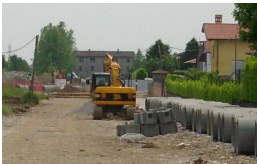
Fig. 1. Stato lavori in tangenziale di Via della Repubblica al 15/05/09
